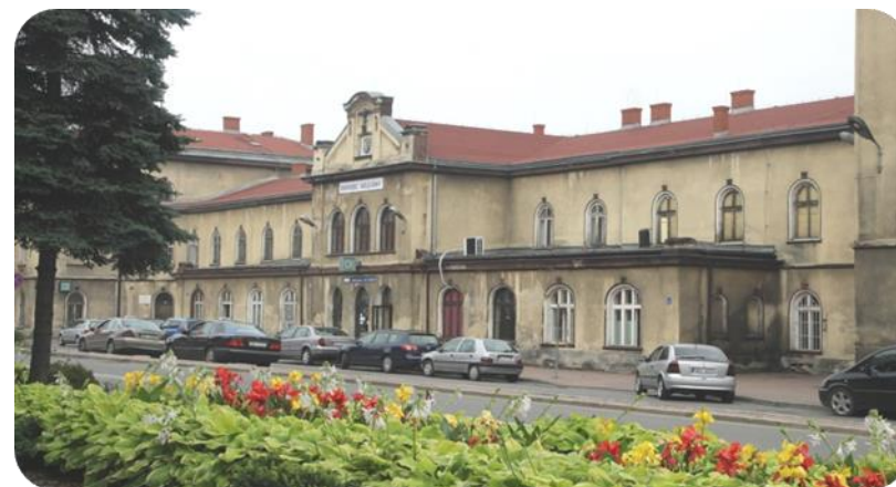
Stan przed przebudową
