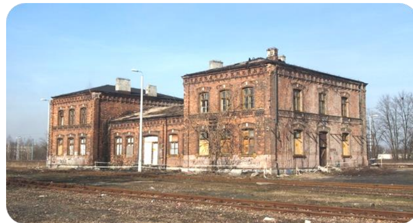
Stan przed przebudową
