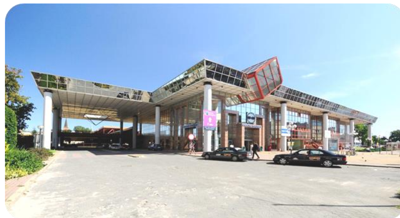
Stan przed przebudową
